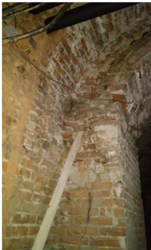
Prostory suterénu a 1.NP – osekane a opadané omítky, trhliny
